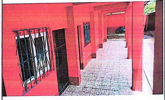
Foto 4: Finalización de Puertas
